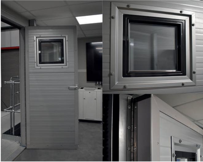
Detalles de las puertas de personal fabricadas con material con aislamiento acústico
