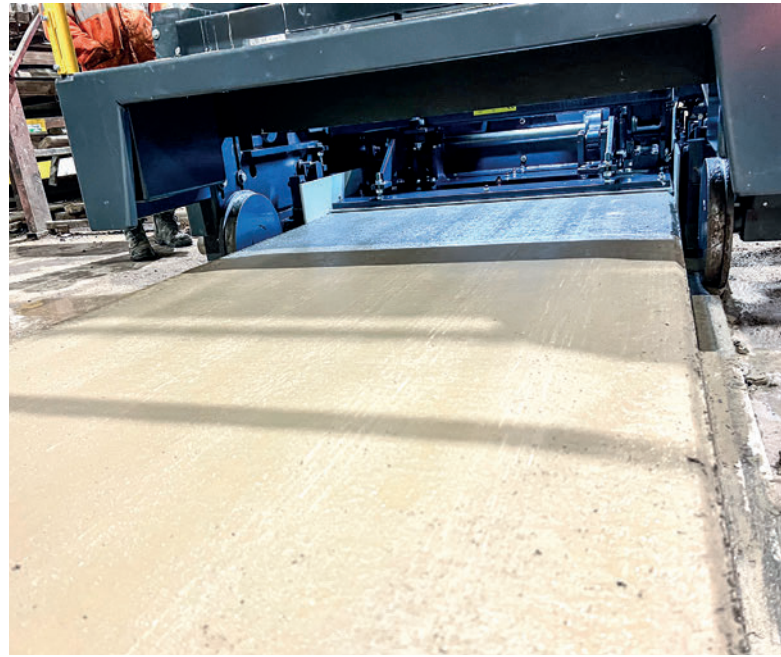
El hormigón se presiona directamente en la pista de producción y permanece hasta su curado detrás de la máquina
