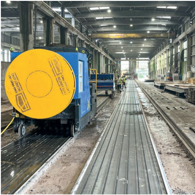
Las placas alveolares pretensadas se fabrican en pistas de 1,2 m de ancho y 150 m de largo
