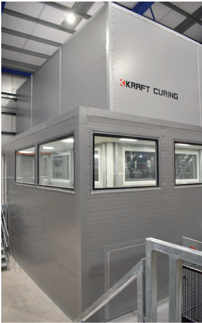
Außenseite des Kontrollraums und des Maschinenraums, vom Werk aus gesehen
