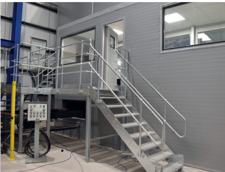
Einmalige Fensterlösungen sorgen für Schallschutz und gute Sicht in das Werk sowie in den Maschinenraum.
