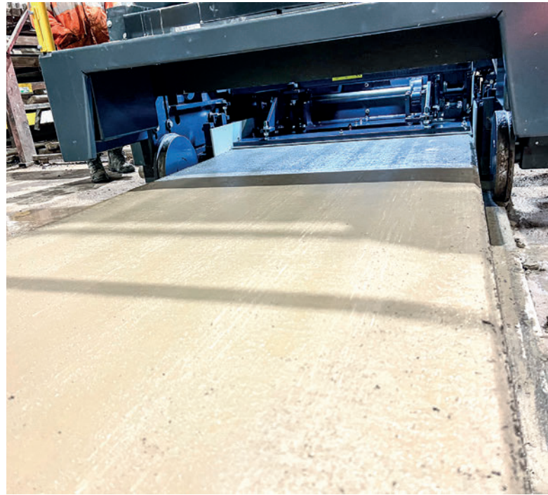
Der Beton wird direkt in die Produktionsbahn gepresst und verbleibt zum Aushärten hinter der Maschine.
