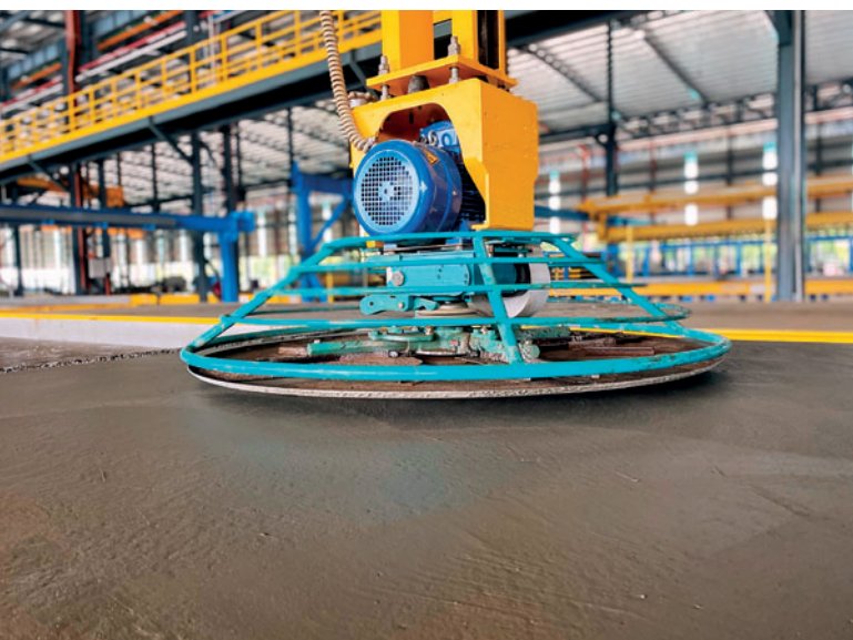
Отделка без усилий: мощная затирочная машина создает гладкие поверхности, устраняя необходимость в покраске
