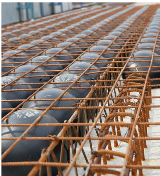
Одним из основных изделий и бестселлером IJM является плита «Bubbledeck»
