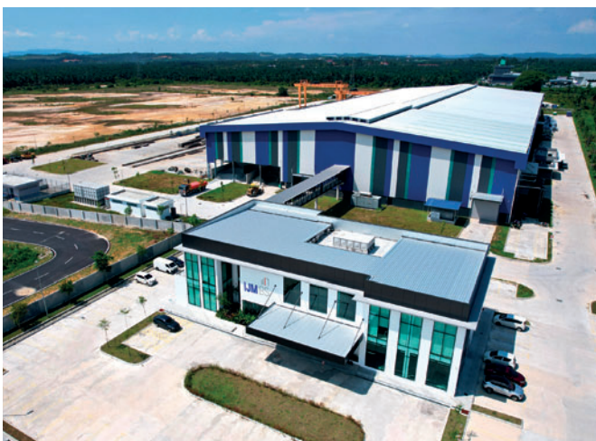
IJM IBS выпускает современные сборные ж/б изделия с помощью автоматизированного оборудования Progress Group в Бестари Джая, Селангор, Малайзия
