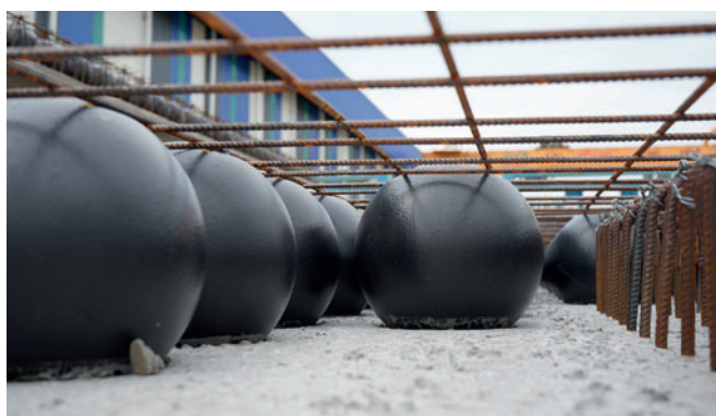
Для снижения веса в инновационной плите «Bubbledeck» используются пластиковые пустообразующие «пузыри»
