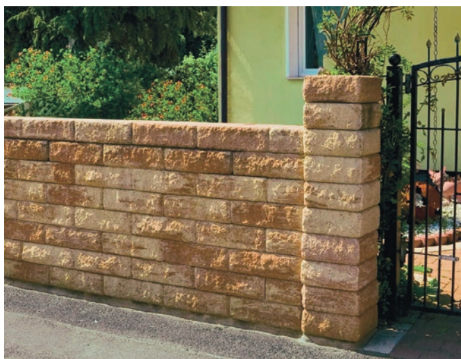
Łupane bloczki murowe i słupek z obrobionymi krawędziami.
