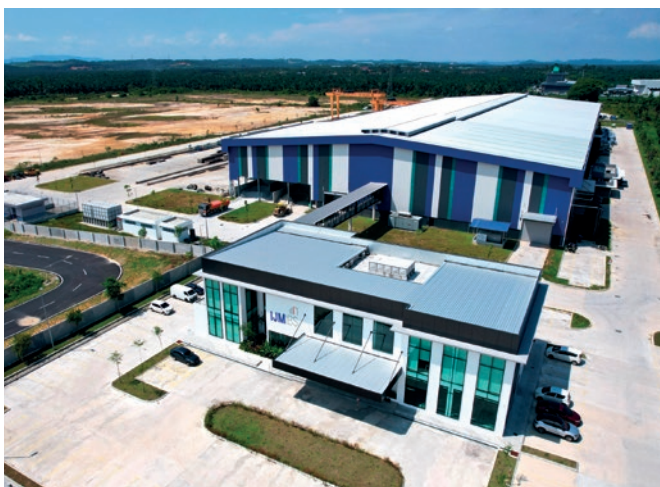
IJM IBS produkuje zaawansowane prefabrykaty betonowe przy użyciu zautomatyzowanych maszyn Progress Group w Bestari Jaya, Selangor, Malezja.
