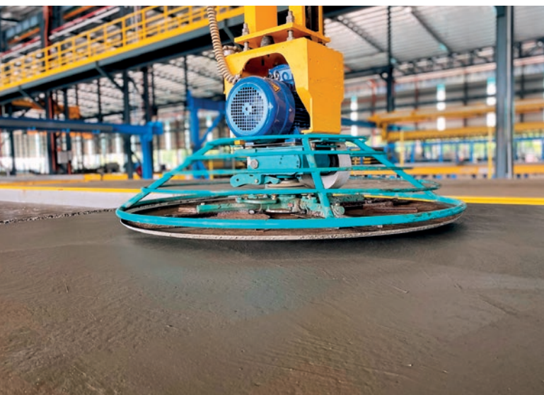
Wykończenie bez wysiłku: zacieraczka mechaniczna zapewnia gładką powierzchnię, eliminując potrzebę malowania.
