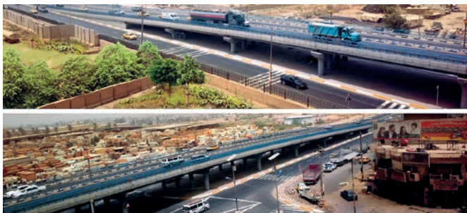
Wiadukt w dzielnicy Shaab. Wiadukt ma cztery pasy ruchu i pół kilometra długości.
