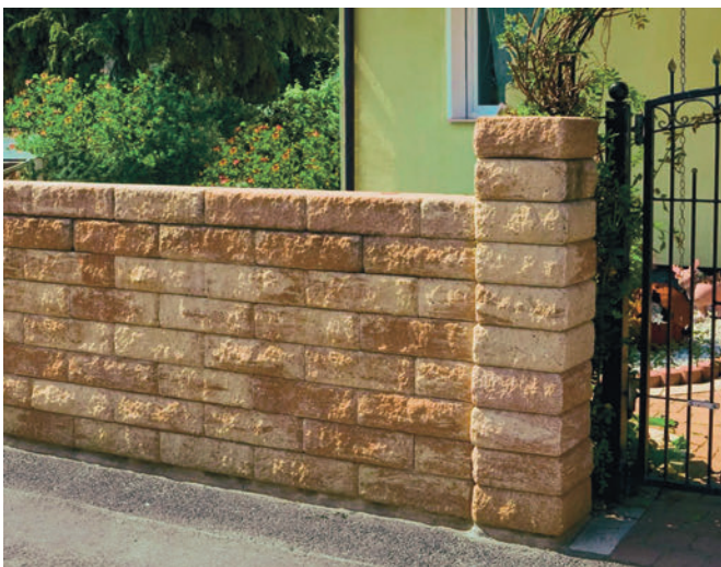
Blocs de maçonnerie fendus et colonne de blocs à arêtes traitées
