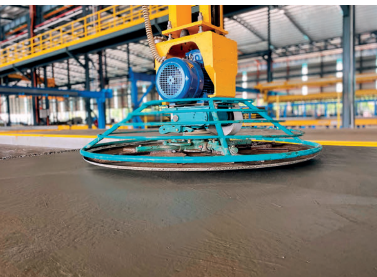
Finition sans effort : la truelle mécanique produit des surfaces uniformes, de sorte qu'il n'est plus nécessaire de peindre.
