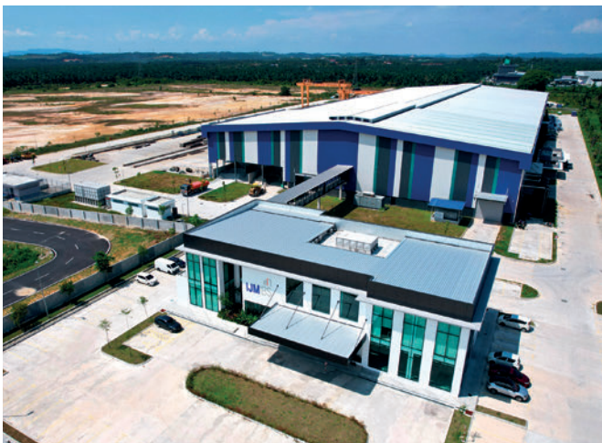
IJM IBS fabrique des éléments préfabriqués en béton avancés avec les machines automatisées de Progress Group à Bestari Jaya, Selangor, Malaisie.
