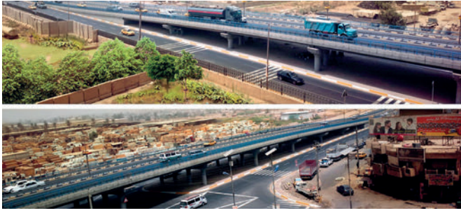
Pont aérien du district de Shaab. Le pont comporte quatre voies de circulation et mesure un demi-kilomètre de long.
