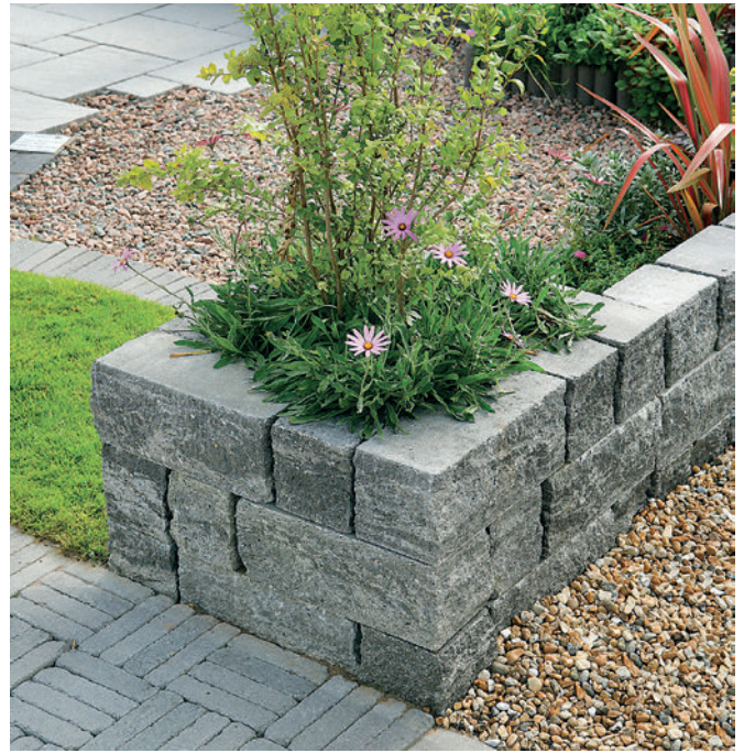
Bloques esplitados con cantos sin mecanizar (cantos rectos)
