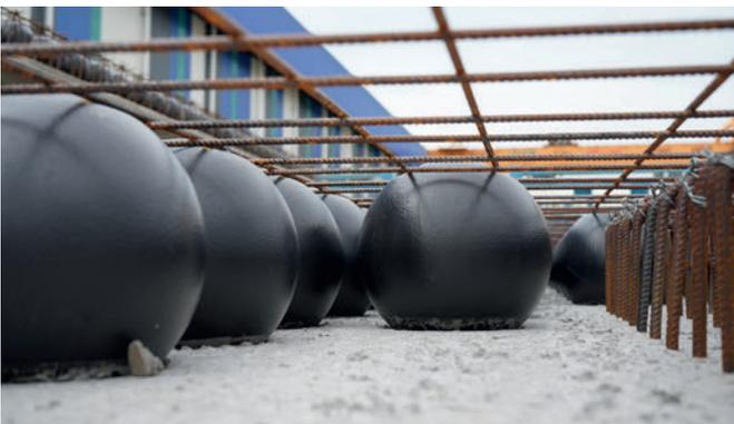
El innovador sistema de losas Bubbledeck reduce el exceso de peso utilizando bolas de plástico como huecos en las placas de forjado.
