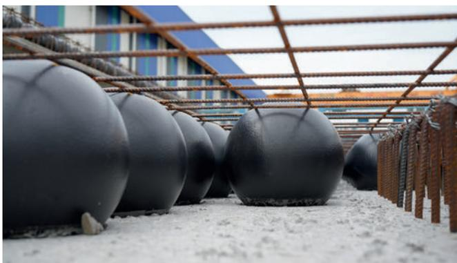
Das innovative Bubbledeck-Plattensystem reduziert überschüssiges Gewicht durch die Verwendung von Kunststoffkugeln als Hohlräume in der Deckenplatte
