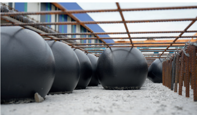
创新型起泡盘板材系统，在地板板材内应用塑料泡沫，移除多余的重量
