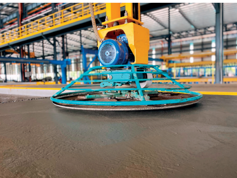
轻松涂装: 混凝土抹光机创造平滑表面, 无需额外喷涂
