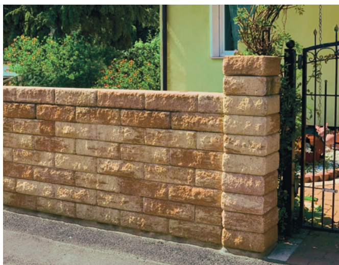
边缘经过处理的带立柱的分体墙石
