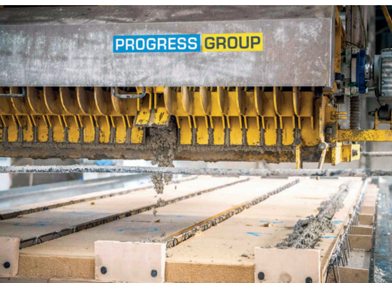
Бетонораздатчик работает точно по рассчитанному количеству и поэтому экономит бетон
