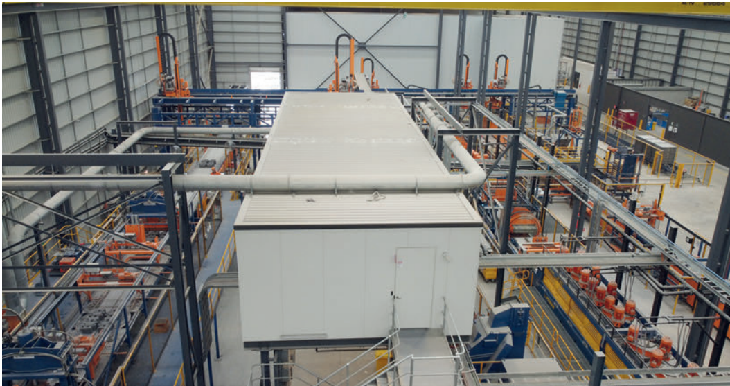
Vue de dessus de la ligne de finition avec la plate-forme pour les armoires électriques
