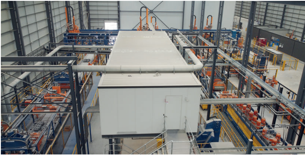
Vista superior de la línea de acabado con plataforma para los armarios de distribución
