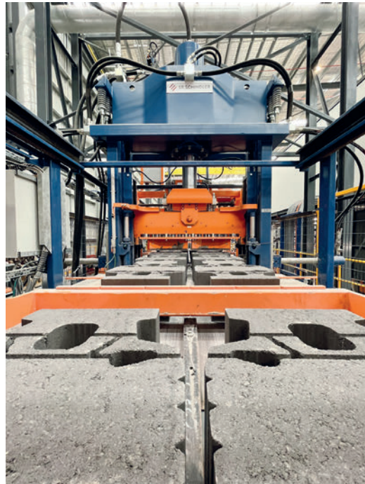
Die Spaltlinie in Betrieb
