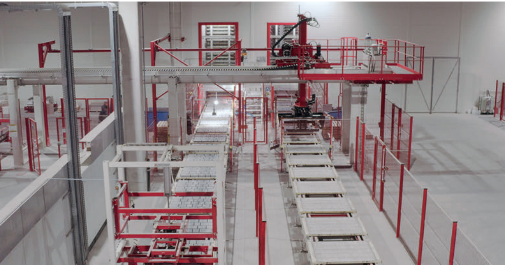
Panoramica generale delle due linee del secco
