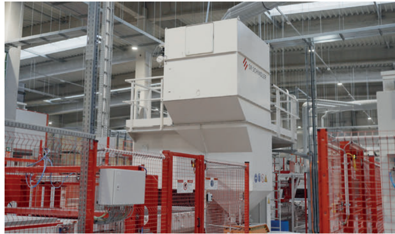
Instalación de granallado
