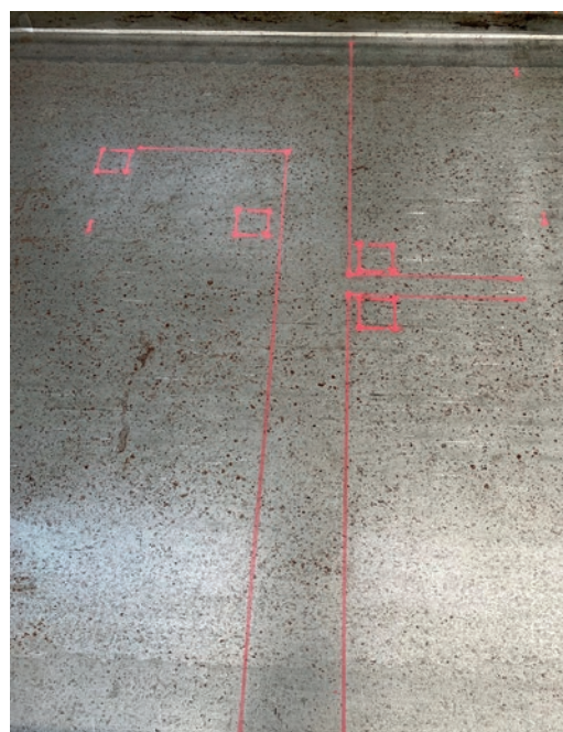
Automatyczny ploter SmartJet umożliwia nanoszenie konturów wkładek formujących, elementów deskowania i otworów.
