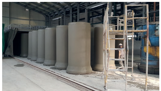
Opuszczające prasę radialną na pierścieniach dolnych rury betonowe DN 1000 z zintegrowaną uszczelką.
