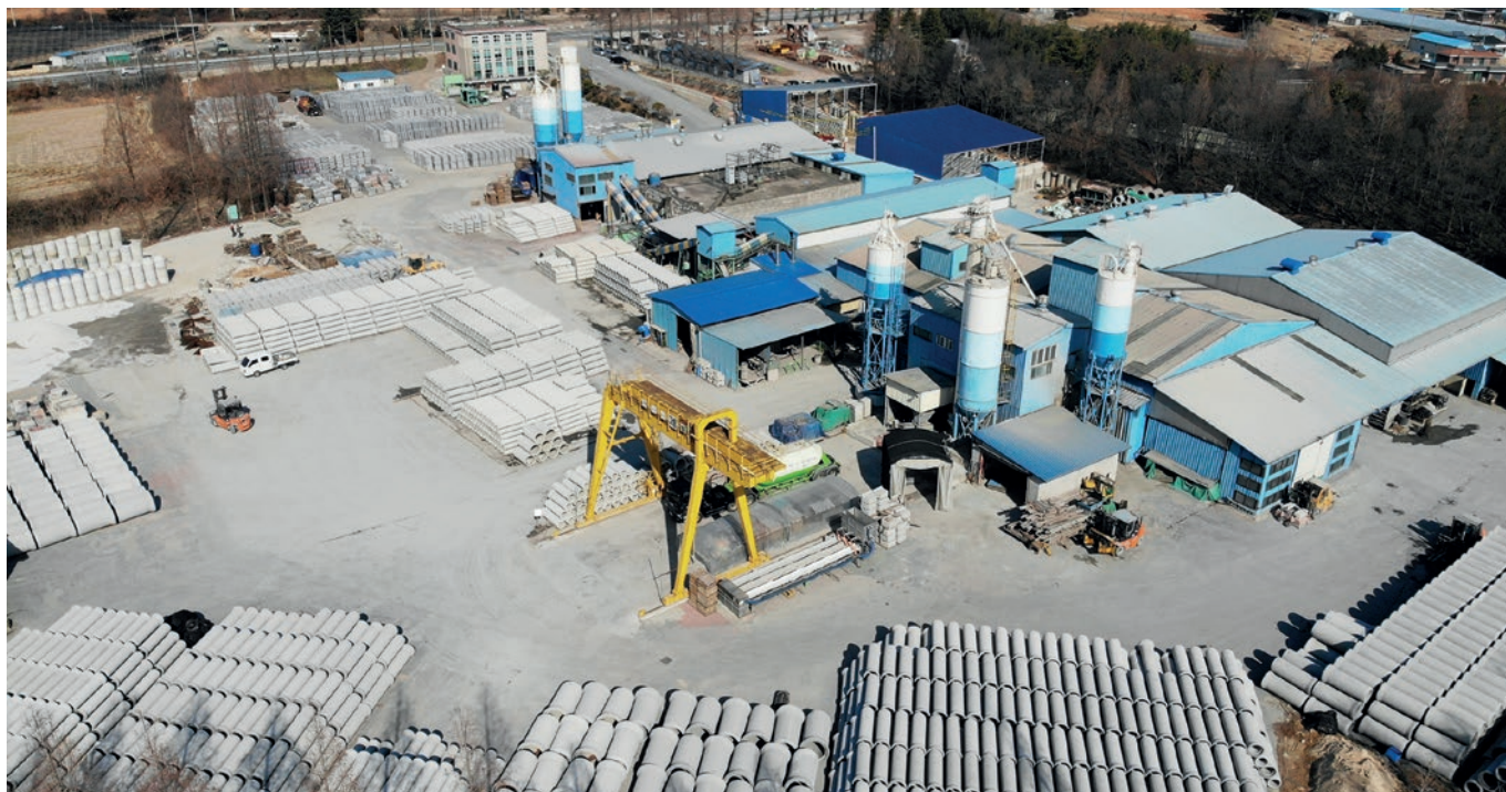
Widok z lotu ptaka na teren zakładu ShinHeung Concrete Co.; Gimje-si (Korea Południowa).
