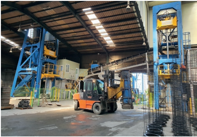
Przygotowanie produkcji rur betonowych.
