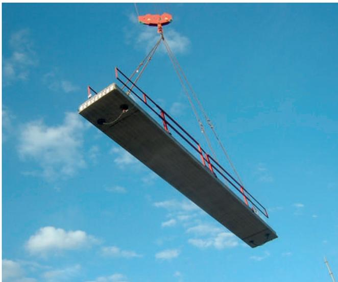
*I solai alveolari precompressi realizzati nel capannone sono poi trasportati nei cantieri e montati nel più breve tempo possibile.*
