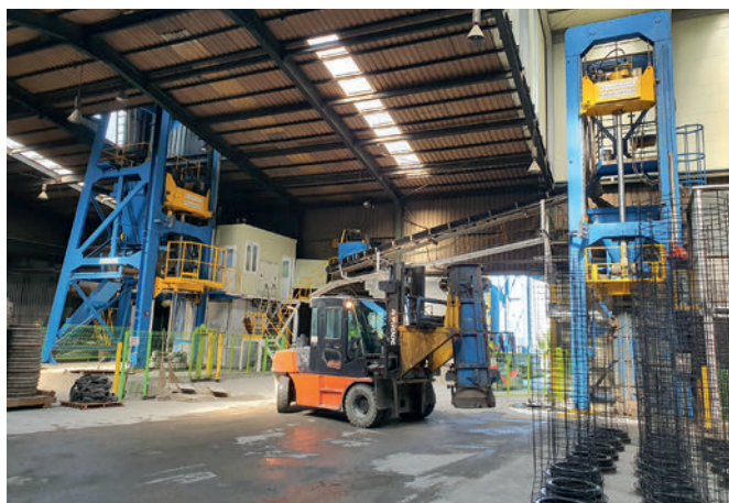
Preparazione della produzione dei tubi in calcestruzzo
