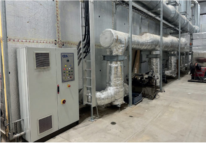
Le système de post-traitement proactif de CDS maintient la température et l'humidité au niveau souhaité.
