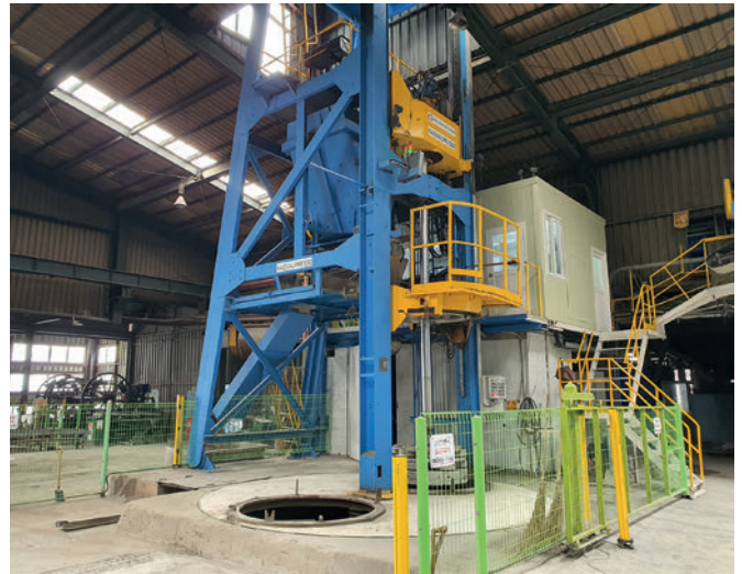
Vista frontal de la prensa radial RP 1230 (año de construcción 1979)
