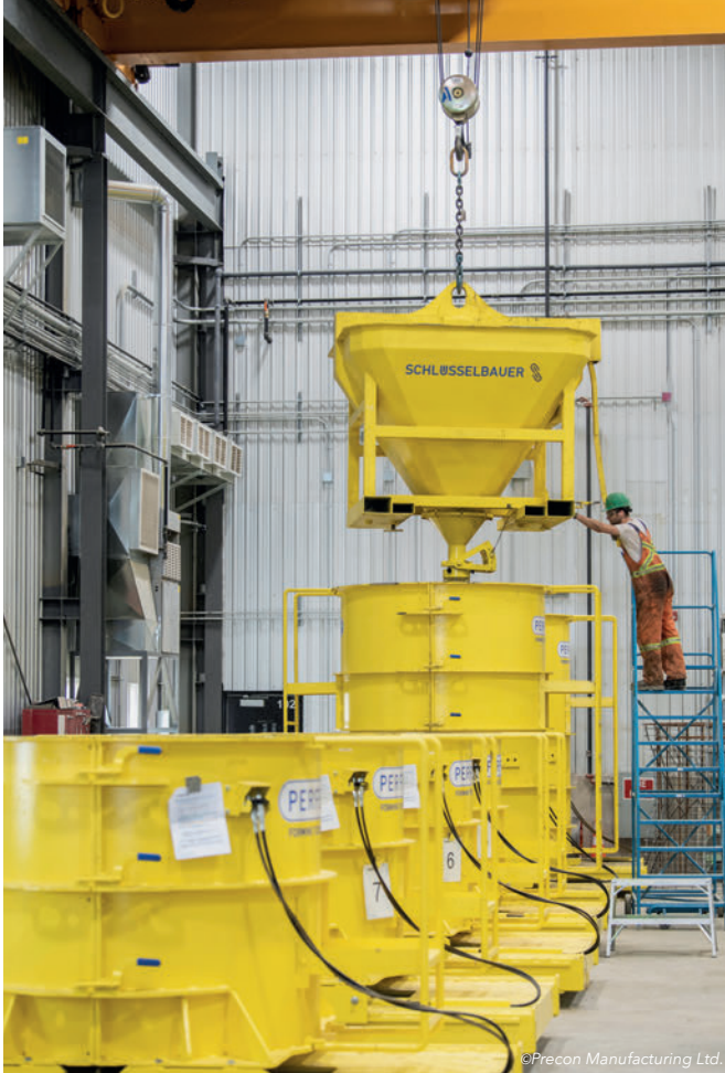
Los moldes para diferentes alturas se rellenan con HAC.
