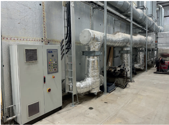
El sistema de curado activo de CDS mantiene la temperatura y la humedad al nivel deseado
