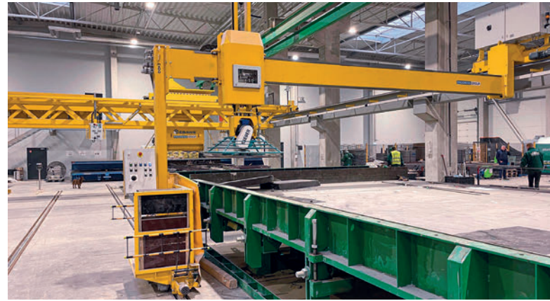
Después del curado, las superficies de hormigón se nivelan con una alisadora de aspás
