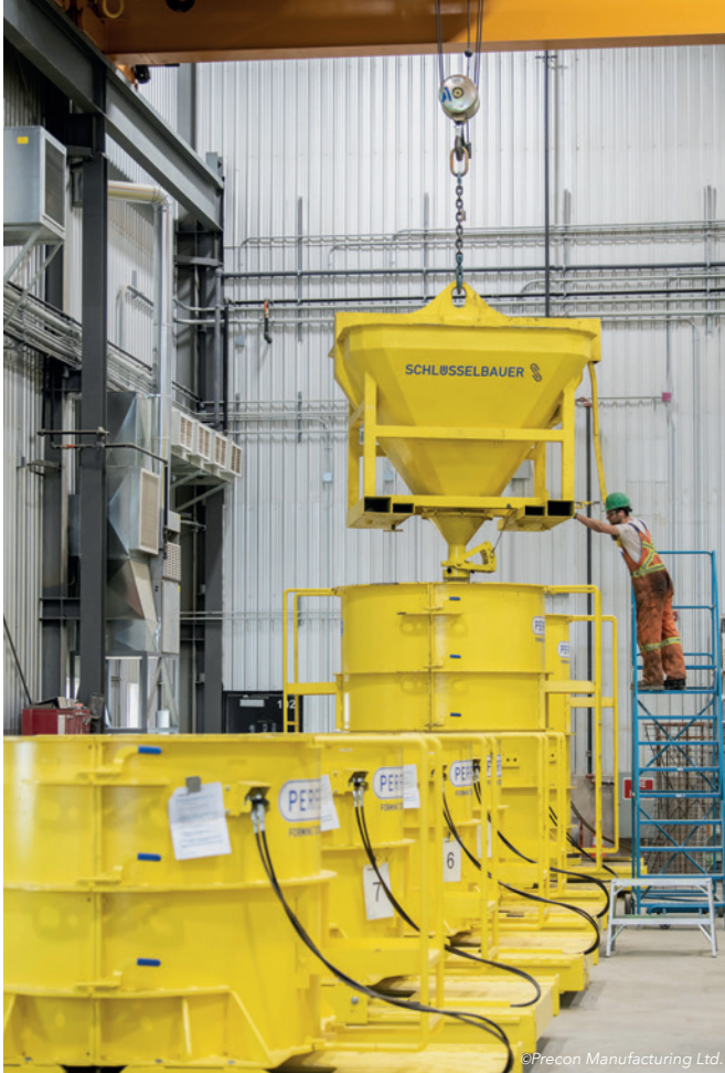
Formen für unterschiedliche Bauhöhen werden mit SVB befüllt.
