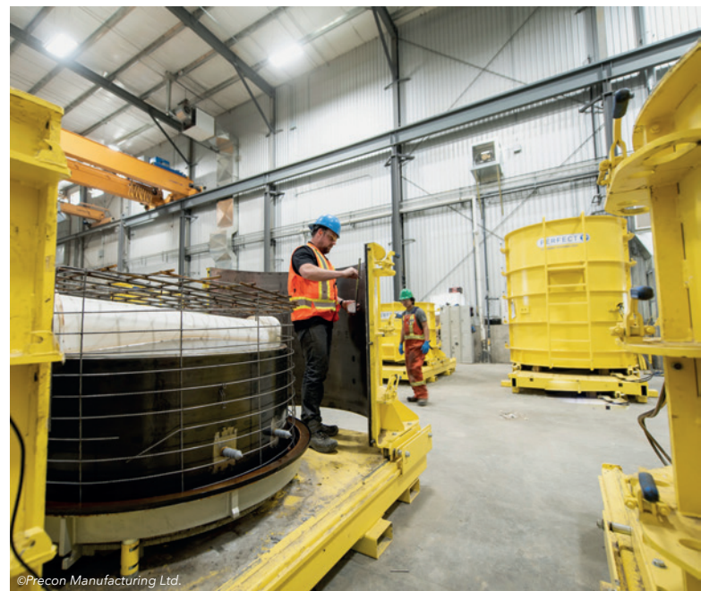
Rüsten von Gerinne, Steighilfen und Bewehrung in Wand und Boden
