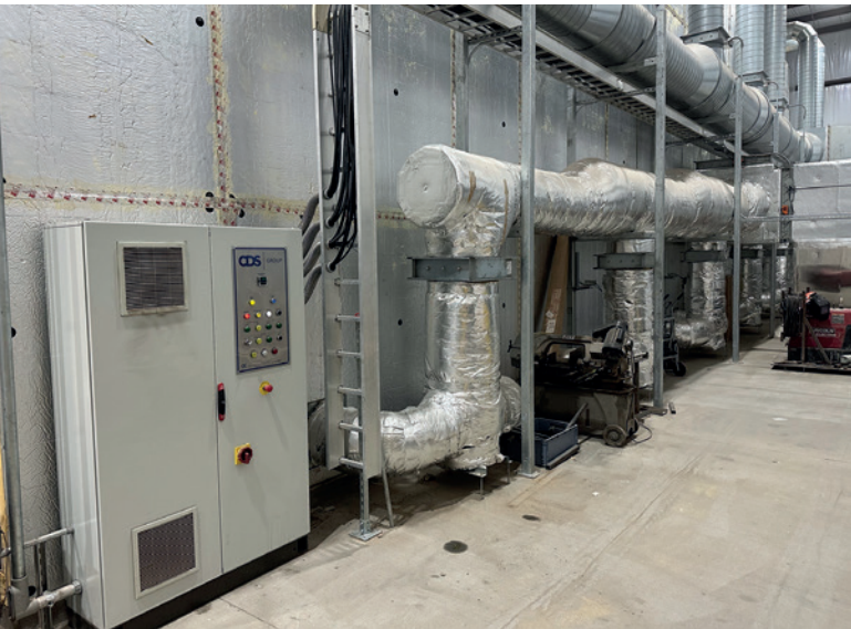
Das aktive Nachbehandlungssystem von CDS hält Temperatur und Feuchtigkeit auf dem gewünschten Niveau.
