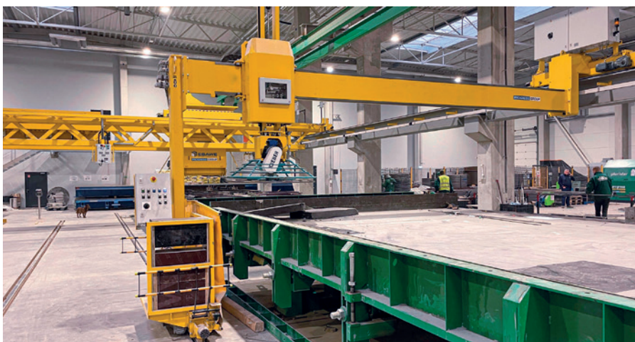
混凝土表面固化后，下一阶段使用电动抹子进行精细平滑
