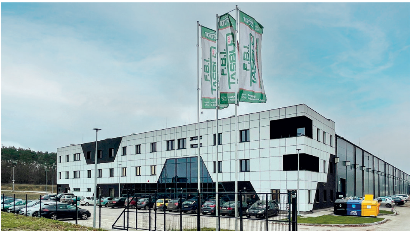
F.B.I.Tasbad 为其预制厂配备了 Progress Group 的自动化机械和软件
