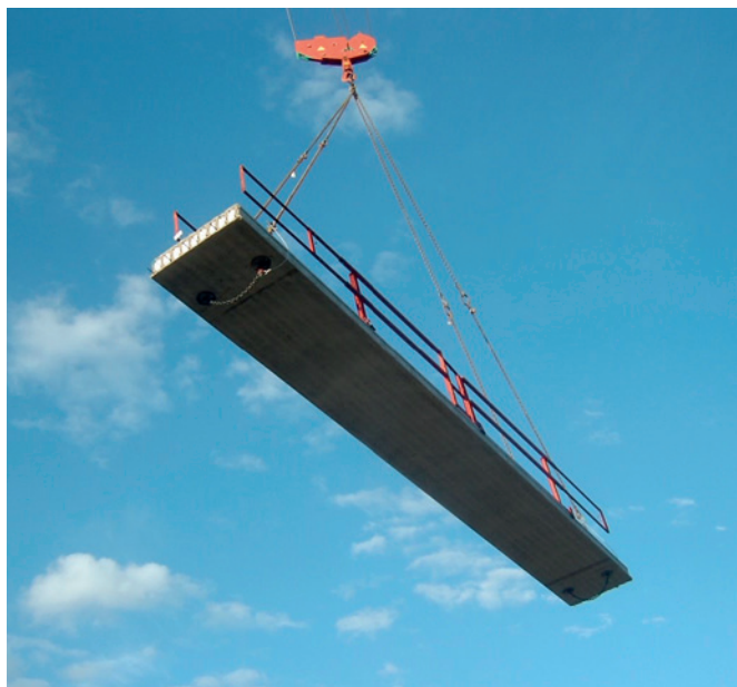
在室内生产的空芯板构件被运送到施工现场，并在短时间内安装
