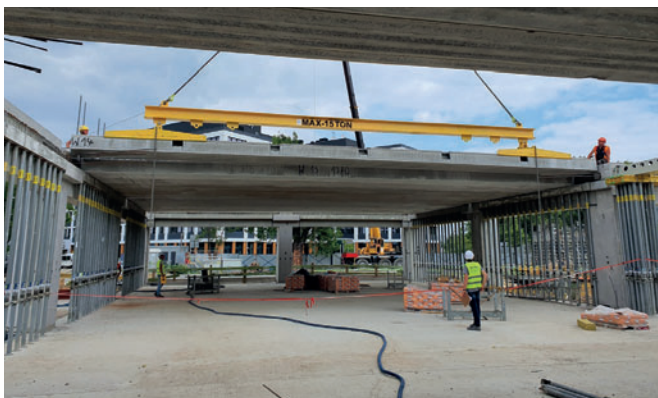
Сборные ж/б элементы – это залог быстрого и безопасного монтажа на стройплощадке
