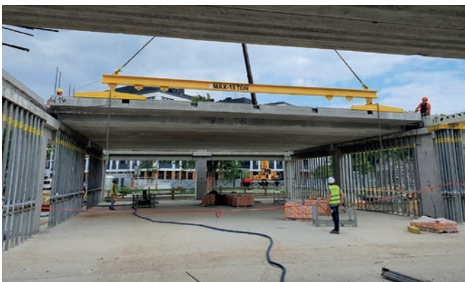
Elementy prefabrykowane mogą być szybciej i bezpieczniej montowane na placu budowy.
