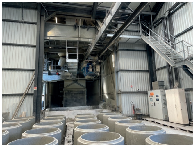
Węzeł dostarczony przez Teka zapewnia dostawy betonu do wszystkich obszarów produkcyjnych.
