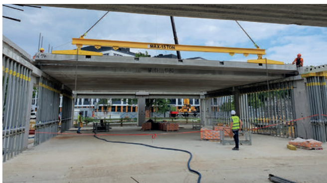
Los prefabricados se pueden usar en obra con mayor rapidez y seguridad.
