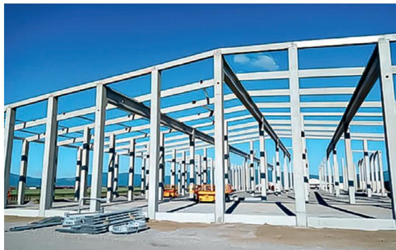
Балки и колонны производятся на заводе, а затем оперативно устанавливаются на стройплощадке
