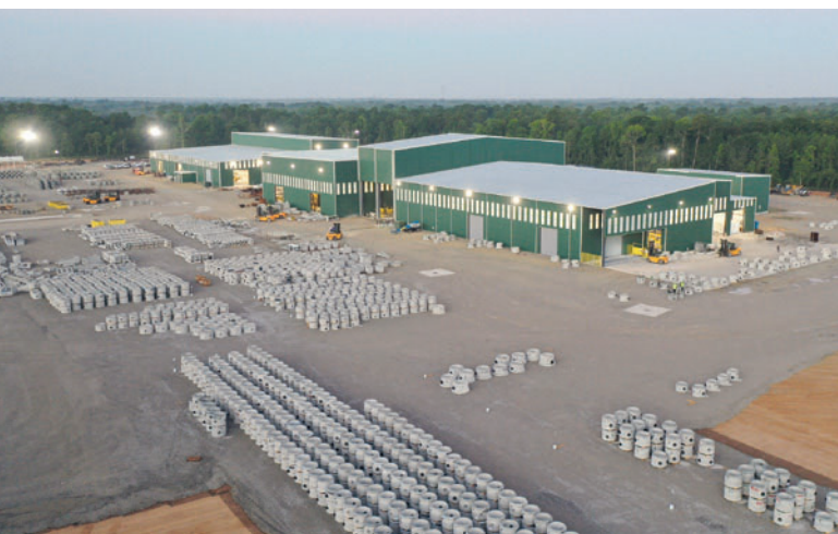
Первый завод компании Ameritex Pipe & Products, который будет оснащен высокоавтоматизированной линией вибролитья от Schlüsselbauer Technology в 2022 году
