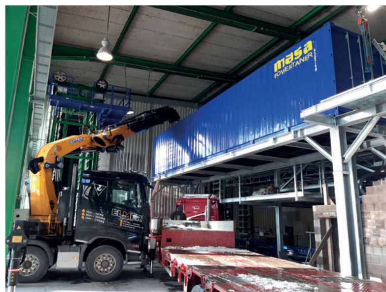
В полностью собранном виде на стройплощадку: Masa Powertainer
