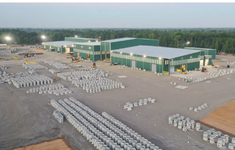
La prima sede di Ameritex Pipe & Products che nel 2022 è stata equipaggiata con un impianto di produzione Wetcast altamente automatizzato di Schlüsselbauer Technology.
