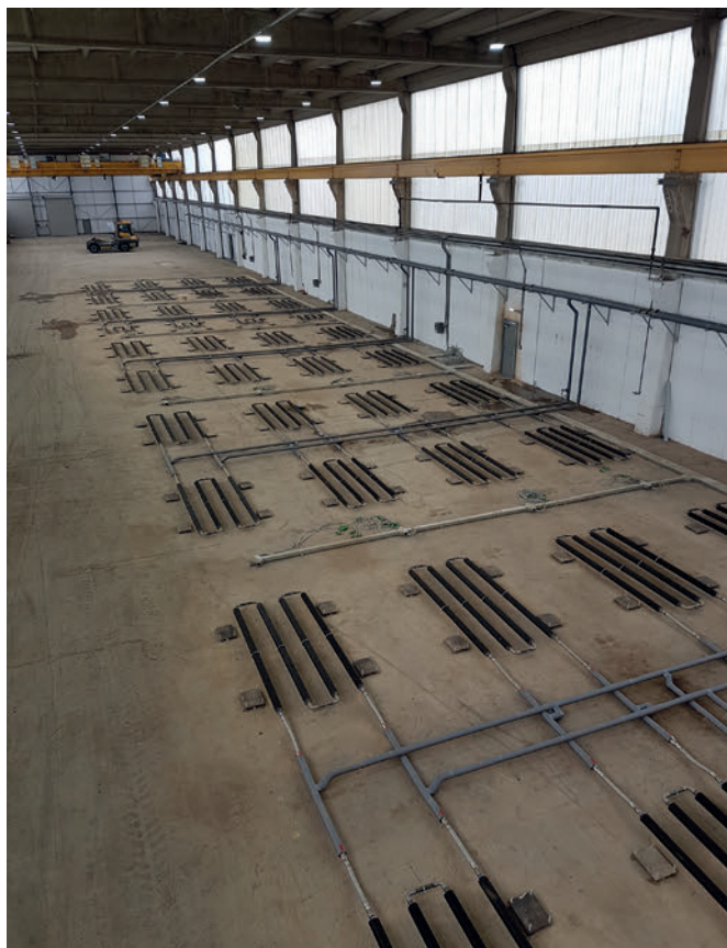
Un sistema di distribuzione del calore progettato da Kraft Curing
