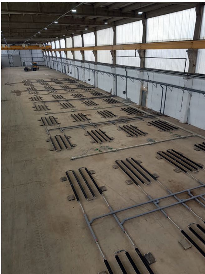
Le système de distribution de chaleur conçu par Kraft Curing
