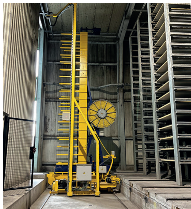
Chiot transbordeur dans l'espace de durcissement
