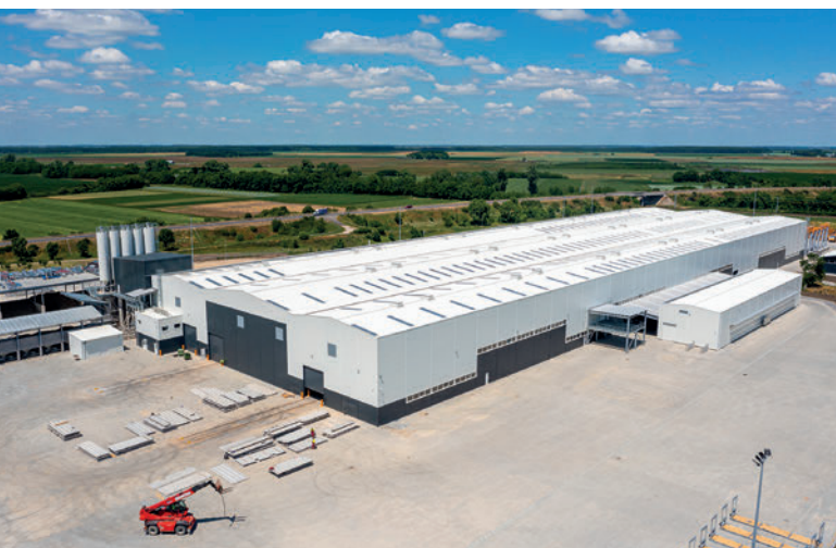
Viastein Kft. pertenece al grupo Bayer Construct y es una de las principales fábricas de prefabricados de hormigón de Hungría
