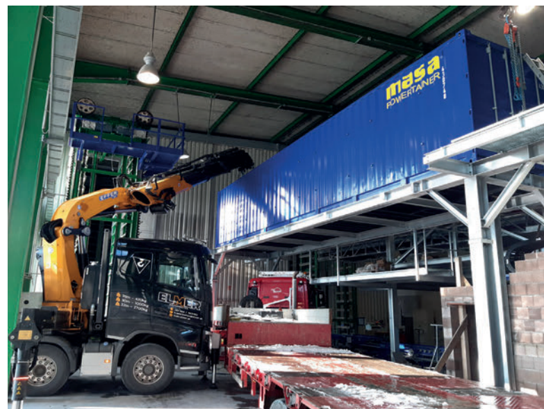
Cableado previo en la obra: el Powertainer de Masa
