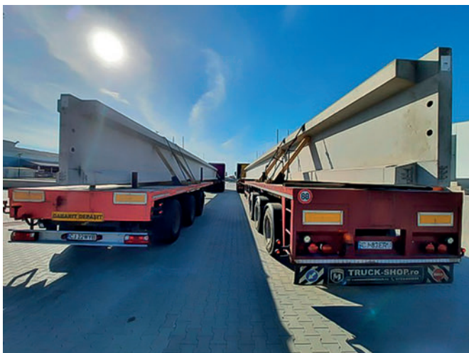
Die Träger und Stützen werden im Werk gefertigt und dann zügig auf der Baustelle eingebaut.
