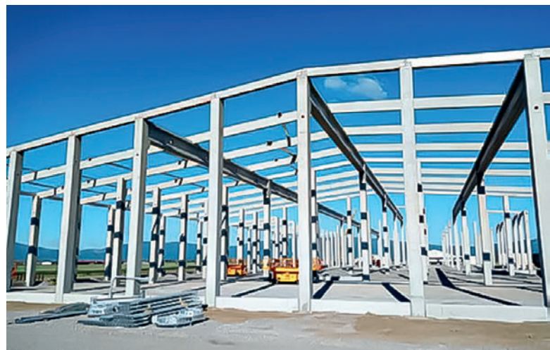
Die Träger und Stützen werden im Werk gefertigt und dann zügig auf der Baustelle eingebaut.
