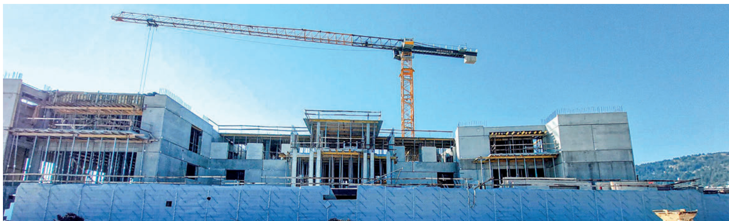
Eines der ersten Großprojekte, das mit den Betonelementen gebaut wurde, war ein Hotel in Gyergyóremete.
