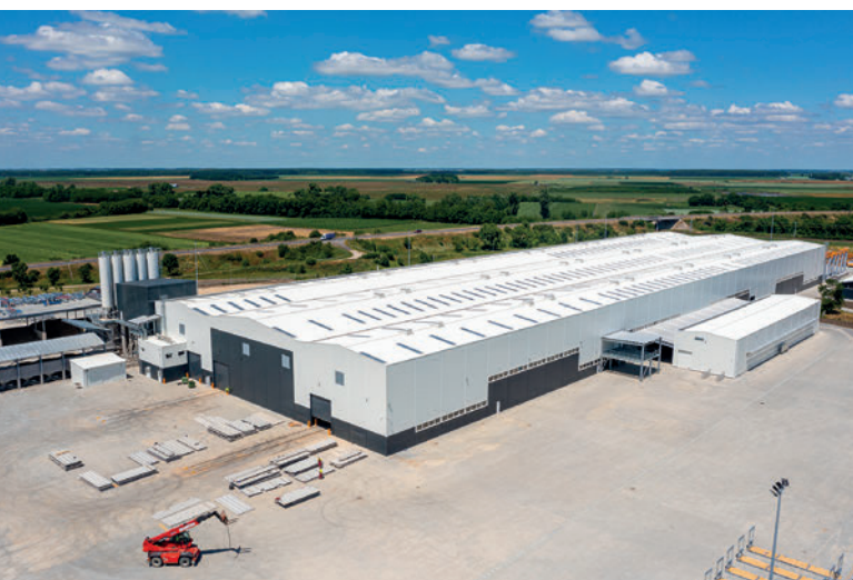
Viastein Kft. gehört zur Bayer-Construct-Gruppe und ist eines der größten Betonfertigteilwerke in Ungarn.
