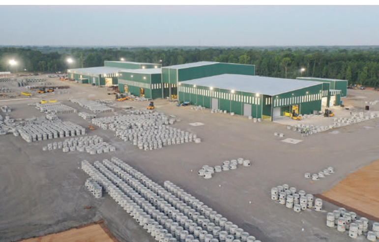
Der erste Standort von Ameritex Pipe & Products, der 2022 mit einer hochautomatisierten Wetcast-Fertigungsanlage von Schlüsselbauer Technology ausgestattet wurde.
