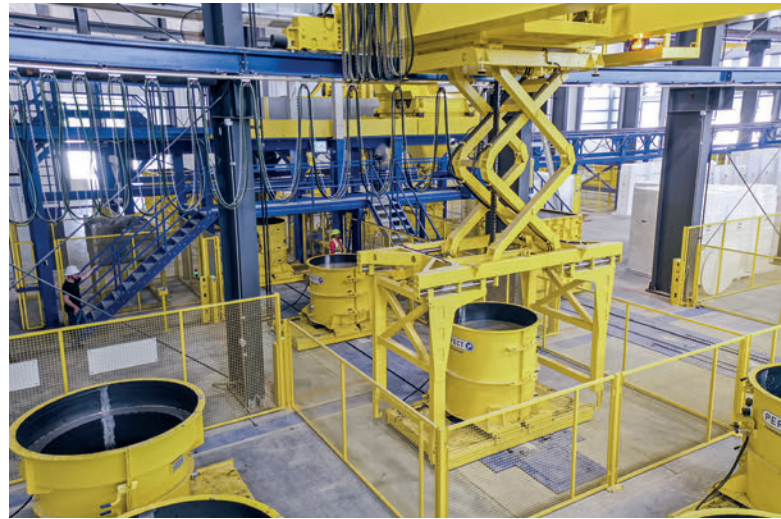
Eine wesentliche Grundlage für den effizienten Betrieb einer industriellen Wetcast-Fertigungsanlage stellt die kontinuierliche Verarbeitung von SVB dar.
